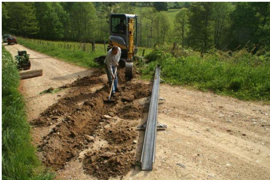
Rigole acier permettant d'évacuer efficacement les eaux de surfaces sur des chemins à forte pente (Sources : journal La Montagne)
